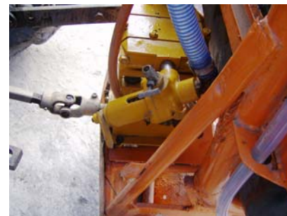
Detalhe: válvula reguladora de Pressão de má qualidade
